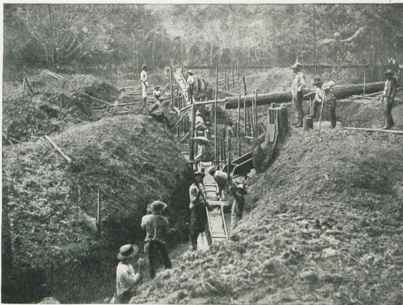
UN SLUICE EN FONCTION.
