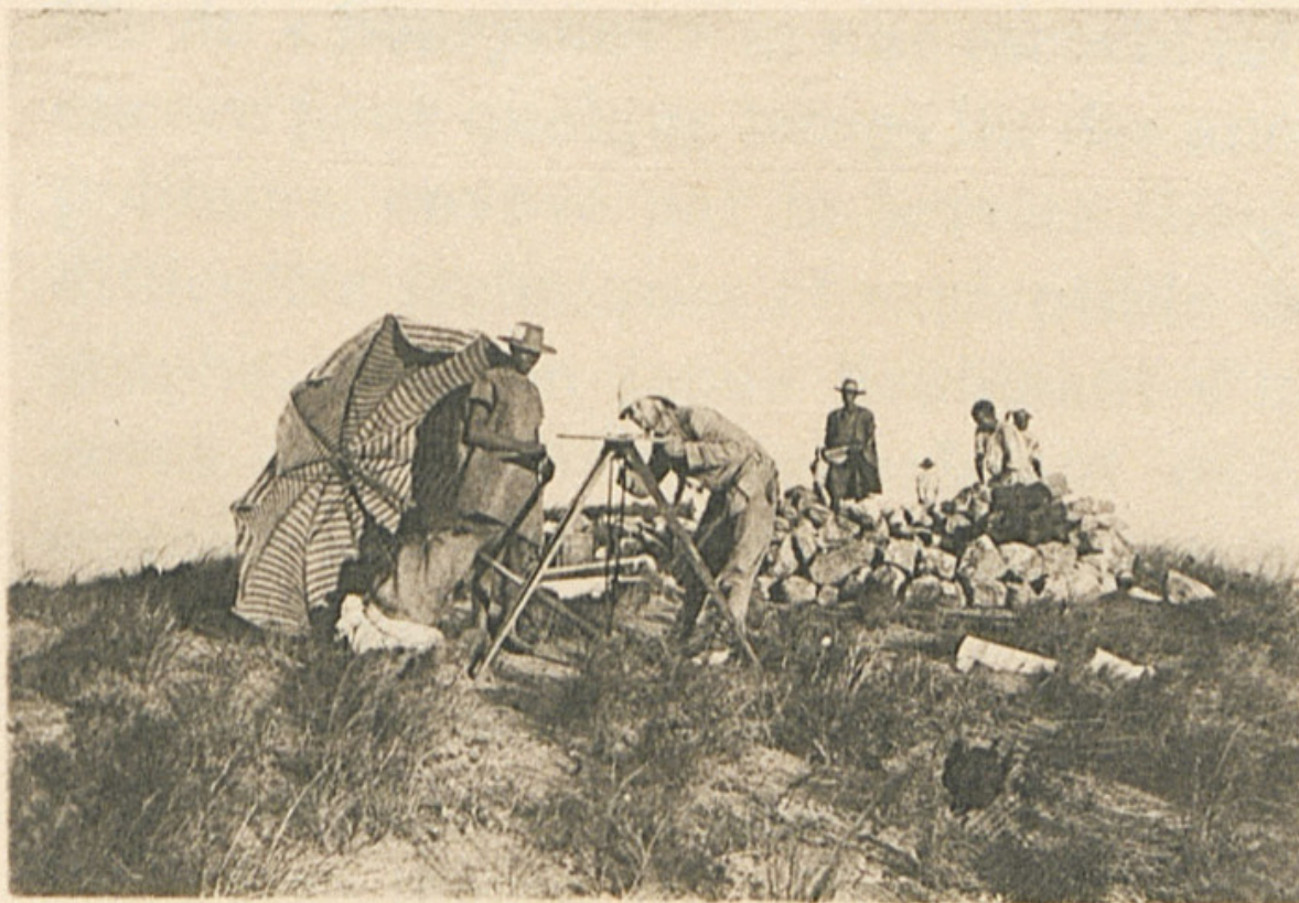
Construction d'un signal géodésique.
