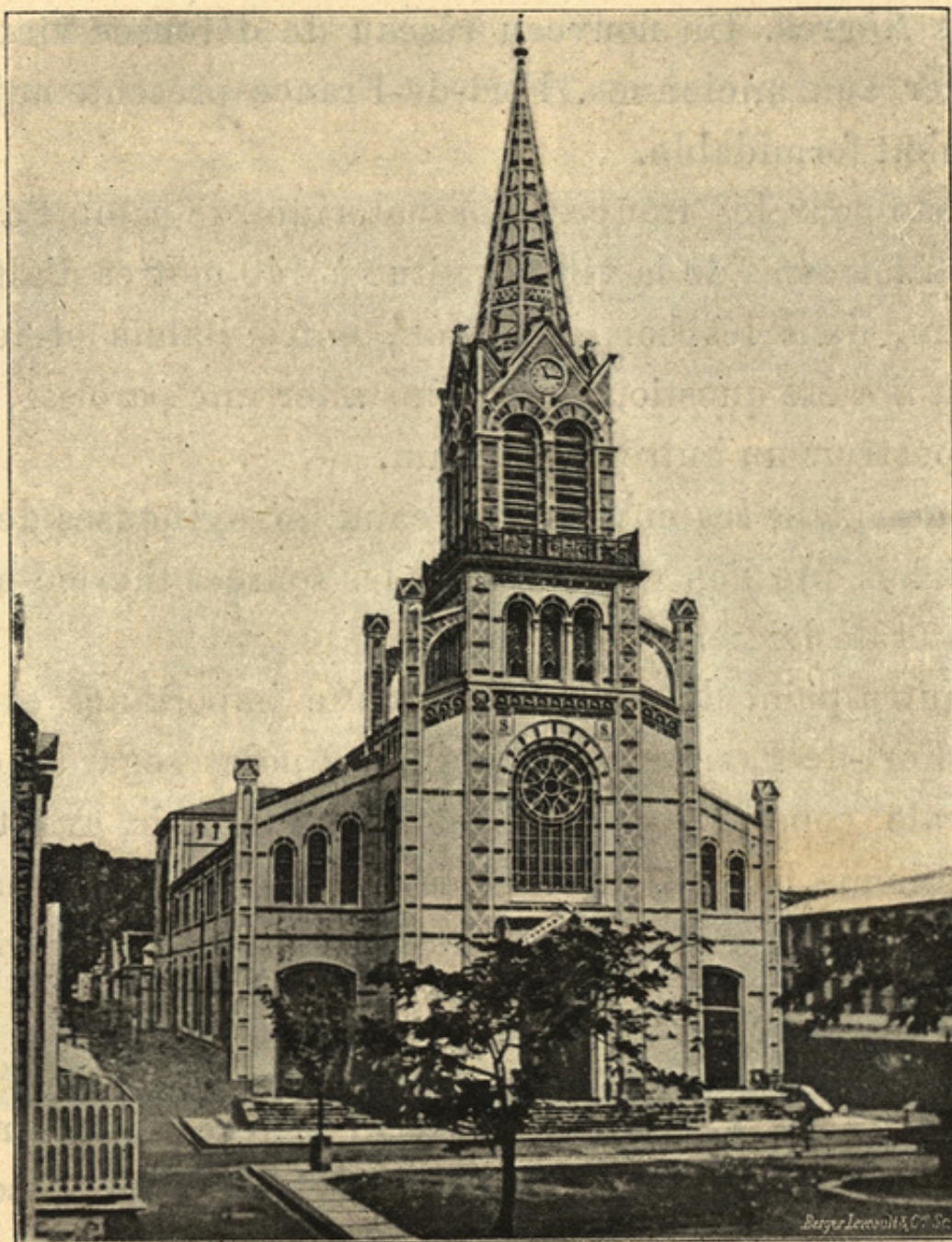
LA NOUVELLE CATHÉDRALE DE FORT-DE-FRANCE
